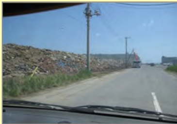
海岸線には瓦礫が山積みになっていました
